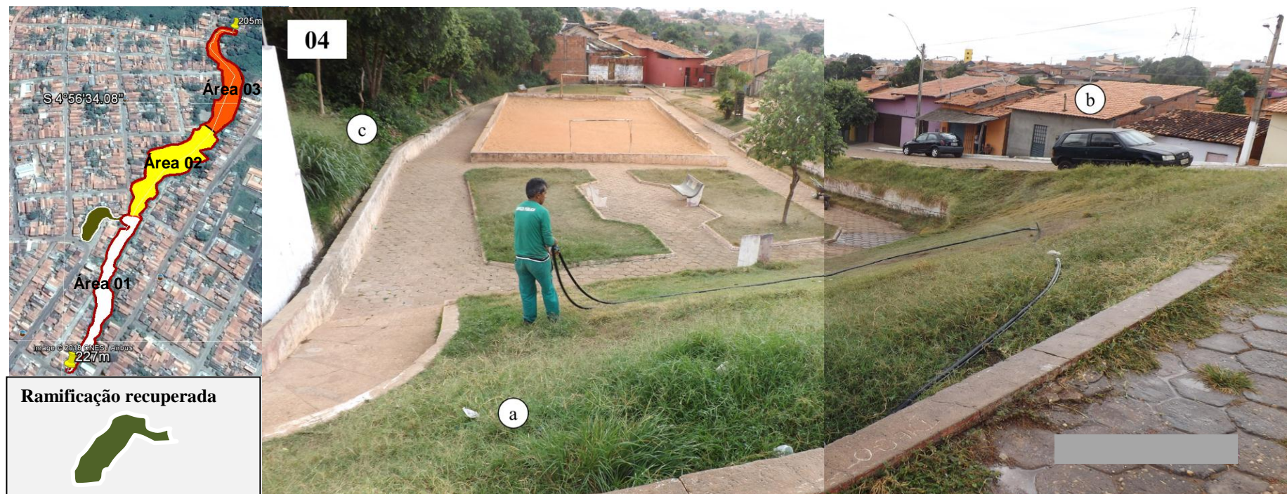
Figura 21: Área de ramificação recuperada da Voçoroca do Bairro Centro. (04) Visão geral da Área 01, região urbanizada.
